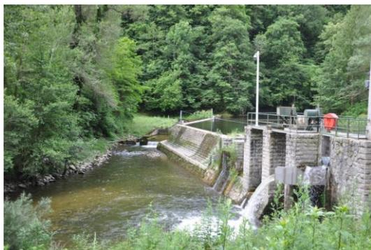
Photo 3 : barrage de St-Georges (10) avec passage au travers (passe à poisson) et voie de contournement (berge)
