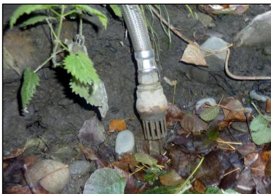
**Photo 1 : Tuyau de captage équipé d'une crépine conventionnelle © F. Blanc**
