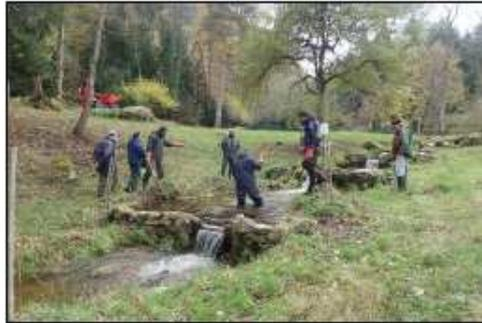
*Illustration 45 : Travaux sur l'ancien canal de dérivation et pêche électrique de sauvegarde avant mise à sec pour les travaux (© ANA)*
