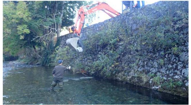
**Illustration 57 : Mise en place des blocs dans la rivière à l'aide d'engins de chantiers.**
